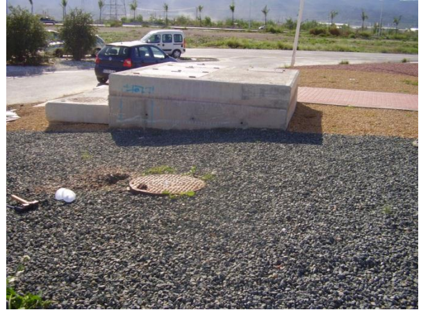
Fotografía 2. Vista lateral norte de la EBAR. En primer plano pozo de acceso a arqueta separadora de caudales.
