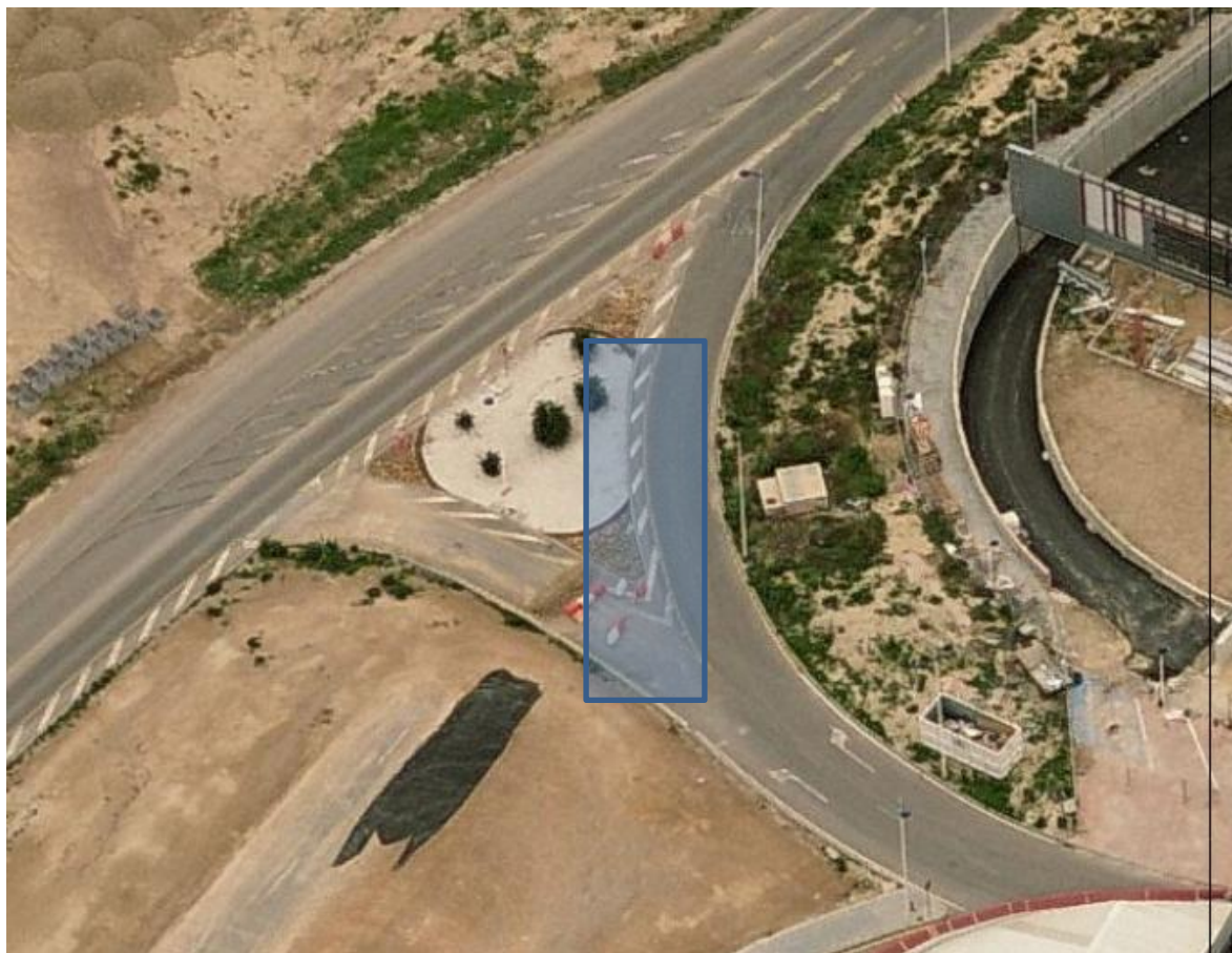
Fotografía 5. Vista aérea de la zona de ubicación del Tanque den Tormentas junto a la EBAR
