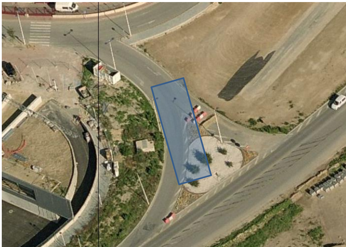
Fotografía 6. Vista aérea de la zona de ubicación del Tanque de Tormentas junto a la EBAR
