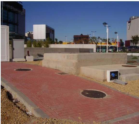
Fotografía 3. Vista lateral sur de la EBAR.
