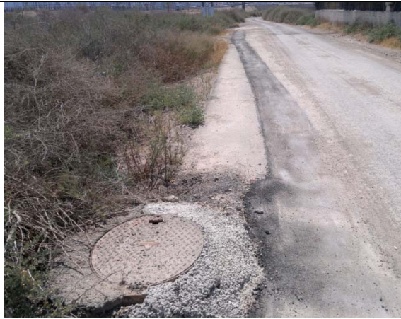
Fotografía 1. Inicio del tramo y pozo 7.
