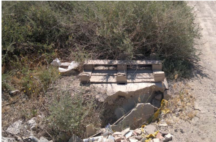
Fotografía 1. Pozo 5, inicio tramo.
